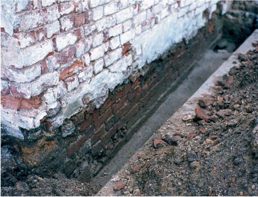
Fig. 1.9. Den nederste del af murværket i korets nordmur set fra øst. Det ses, at lige under terrænhøjde er der et spring i murværket, hvor teglstensskallen i den øvre del har sluppet murkærnen. Foto: Jens Velle 1984, Viborg Stiftsmuseum.
