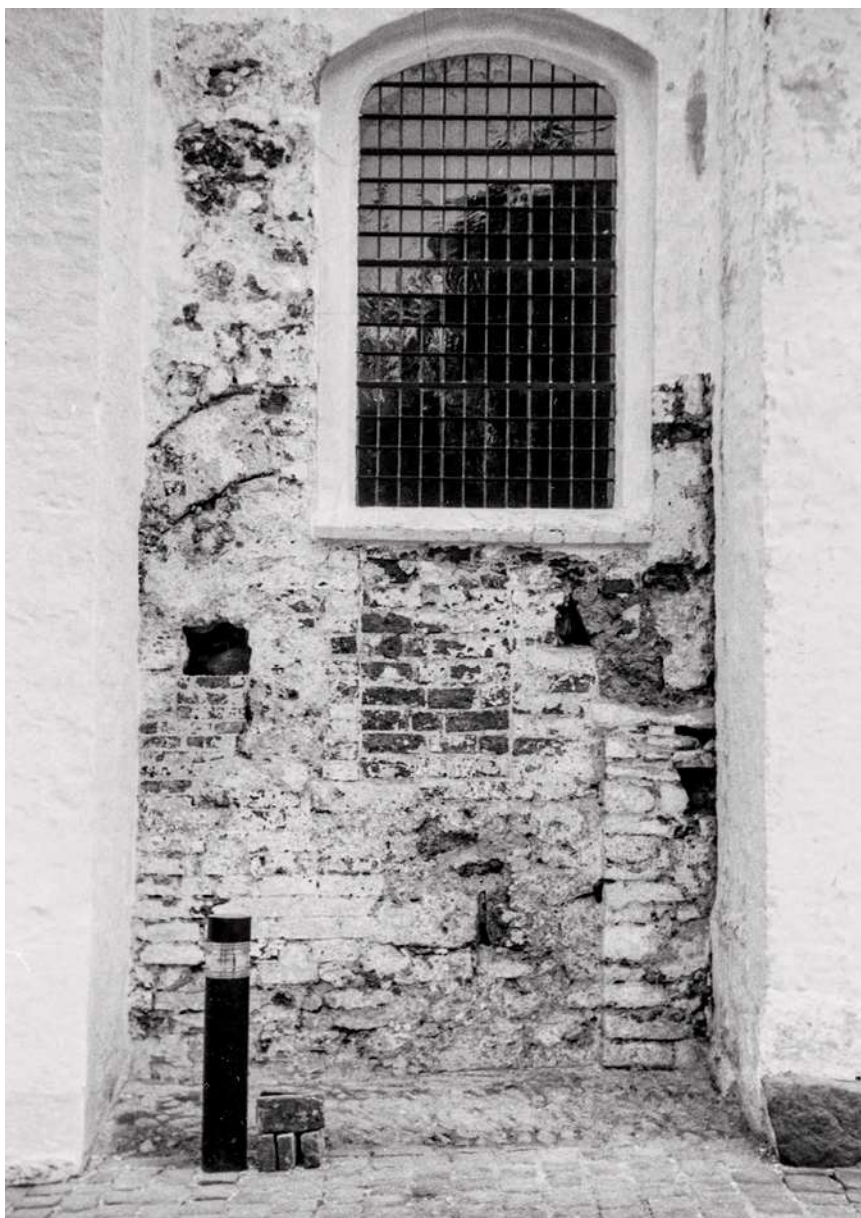
Fig. 1.8. Afbanket murværk ved skibets østligste arkade. Fjernelsen af pudsens afslører dels rester af stikket over åbningen og dels et lukket vindue i arkadens tilmuring. Foto: Jens Vellew 1979, Viborg Stiftsmuseum.
